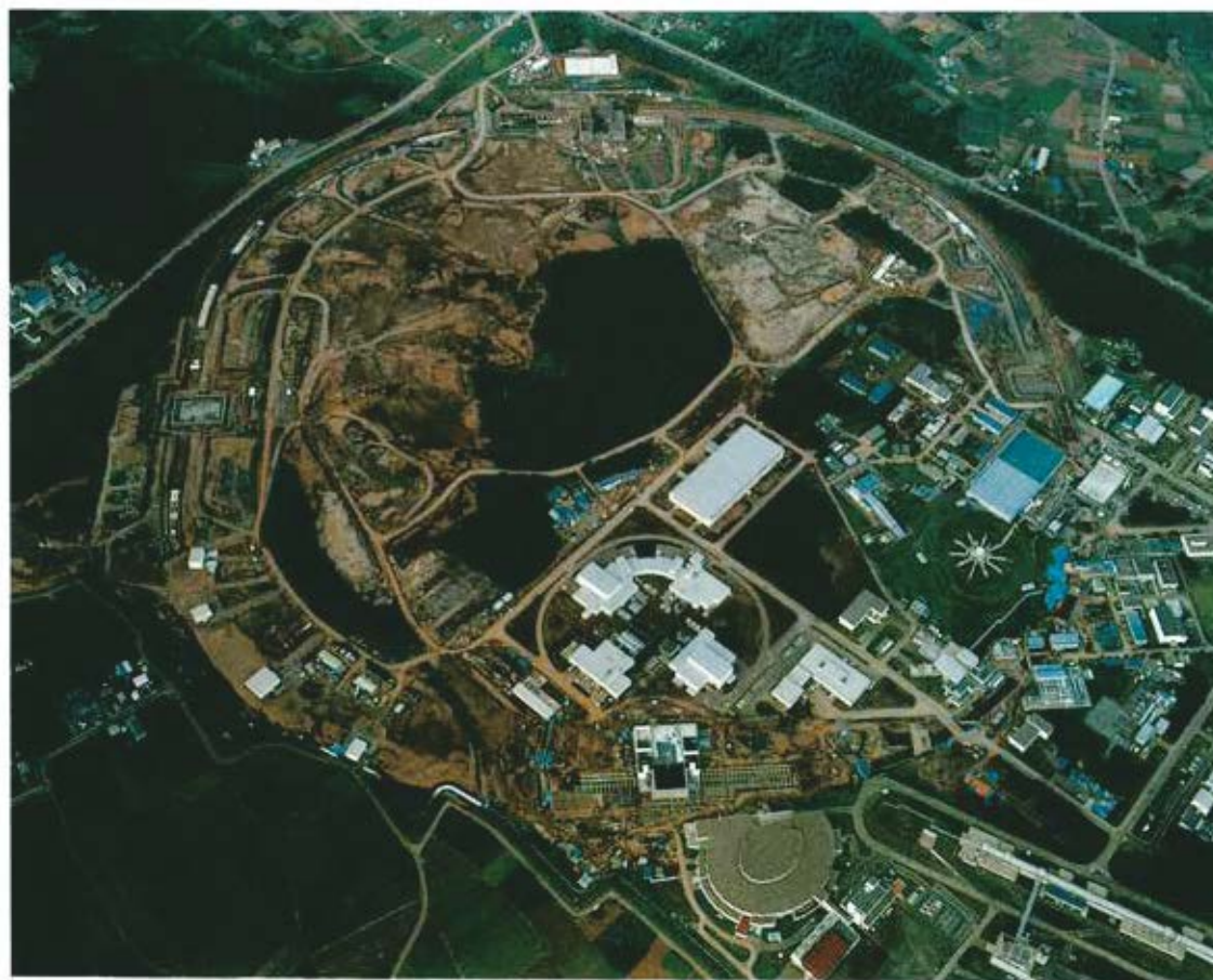
図39 KEK のトリスタン計画の最近の建設状況
