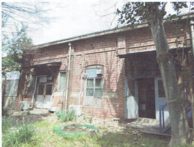
物理試験室D棟（明治40年築）
